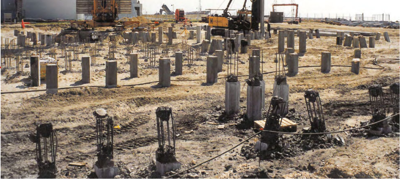
Sprængte pæle på Avedøreværket 1999
