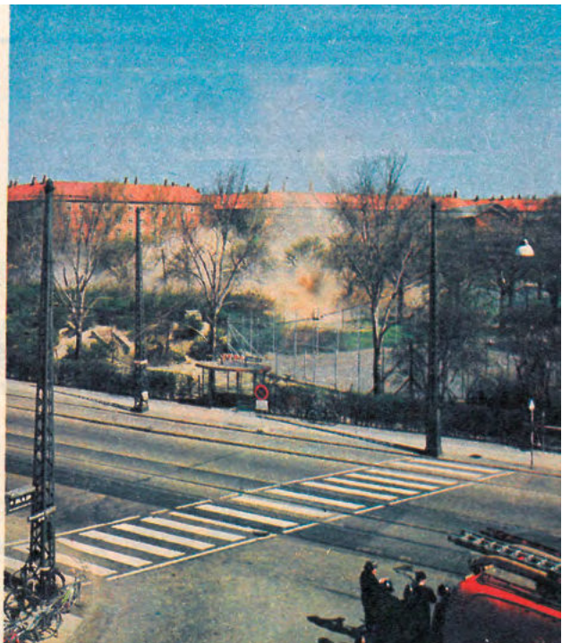
Sprængning af Sundby Vandtårn, 1967. For at få bedre virkning af sprængningen og for at dæmpe udkast fra sprængning var tårnet \frac{3}{4} fyldt med vand
