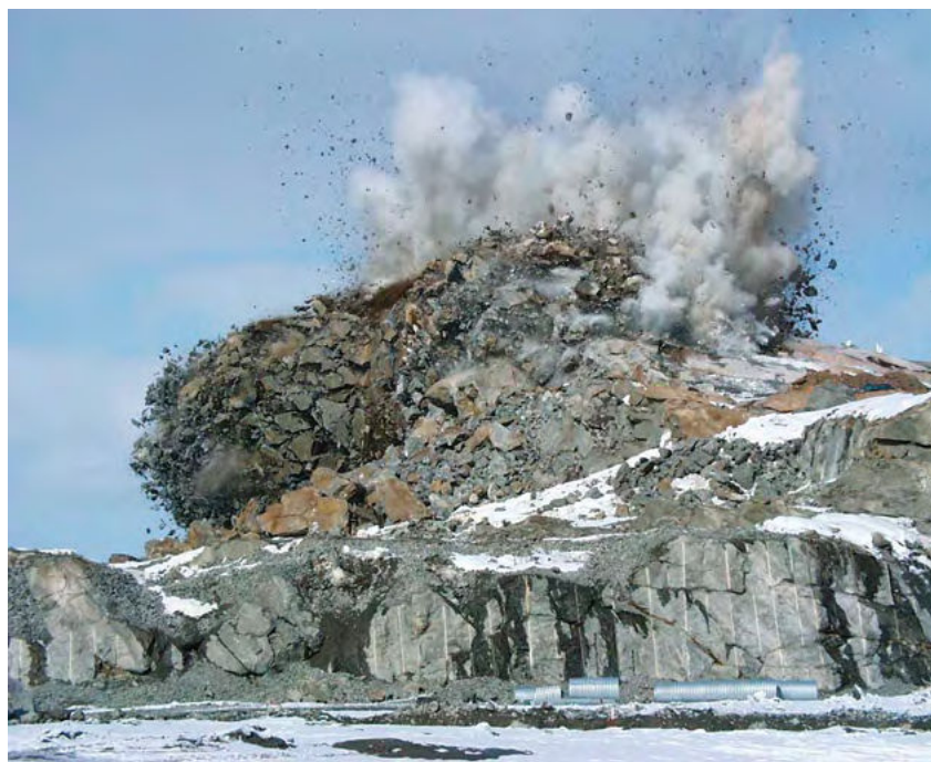
Sprængningsarbejde i Upernavik
