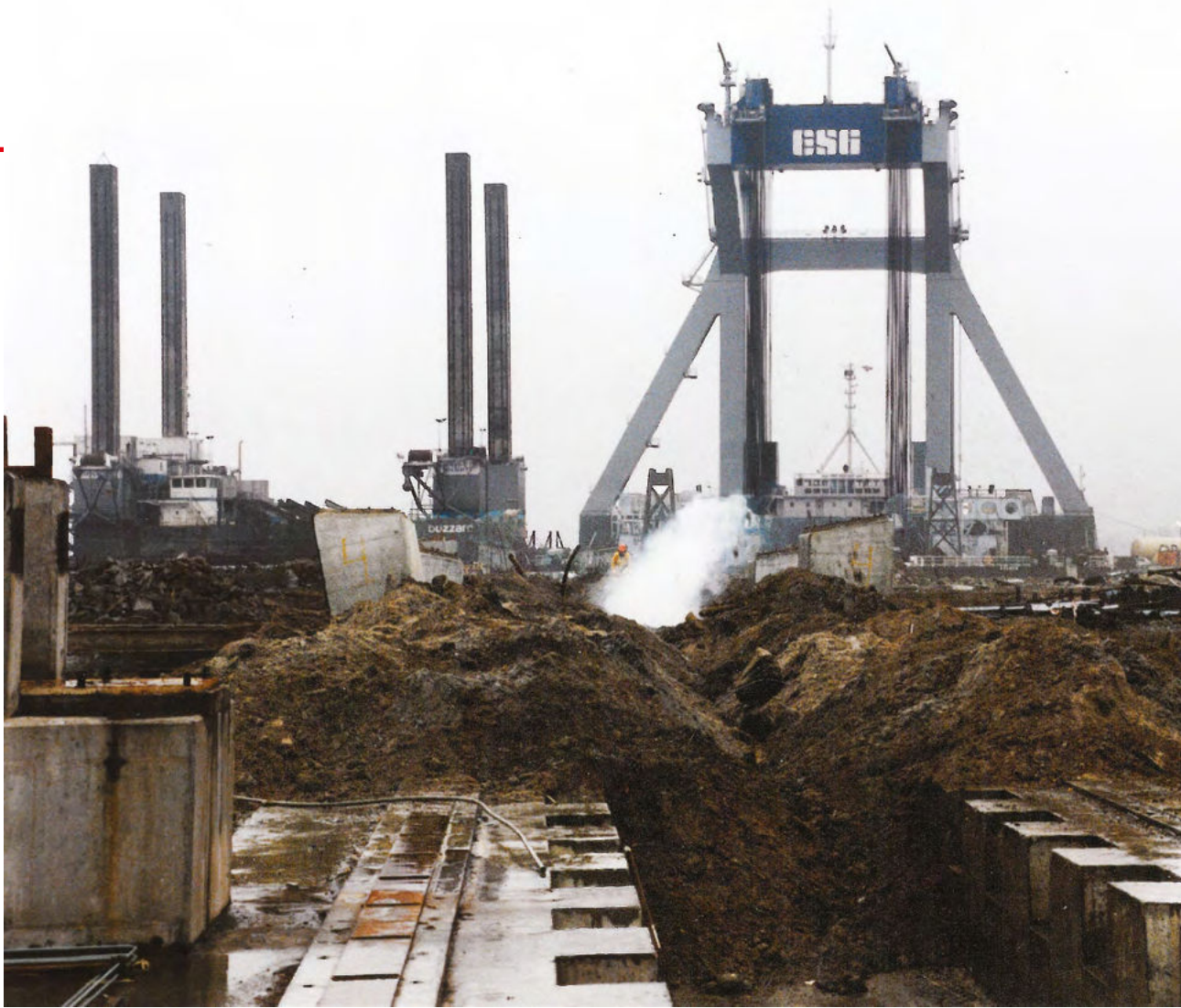
Sprængning af betonkonstruktion afdækket med jord, betonelementfabrikken på Lindholm 1994
