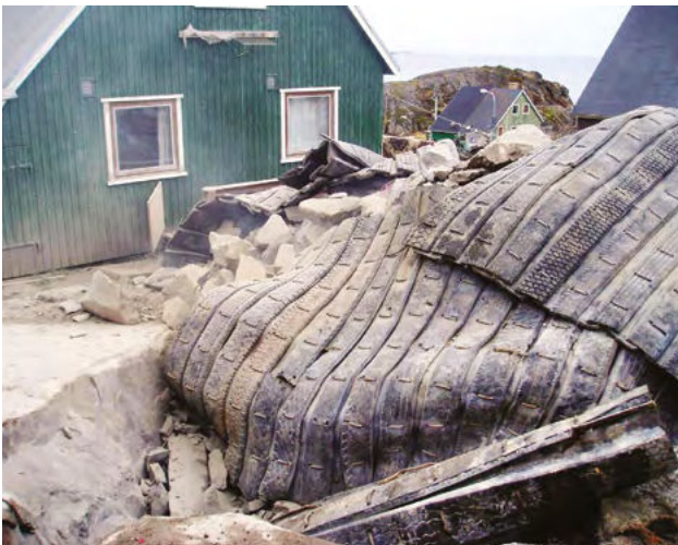
Sprængningsarbejde for byggemodning ved sygehuset i Uumannaq (foroven og nederst til højre) og for at skabe plads til ny vej i Sisimiut (nederst til venstre og foregående side)
