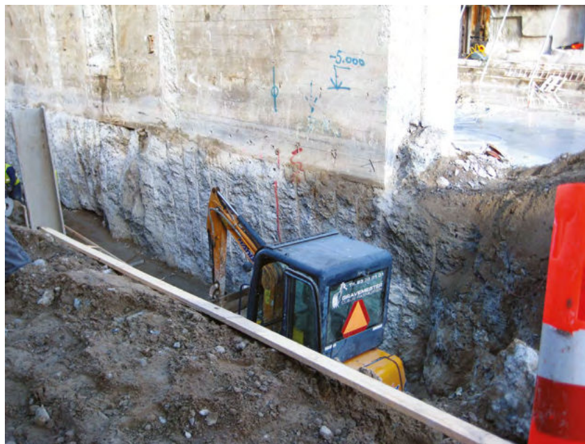
Udgravning ved fundament efter sprængning
