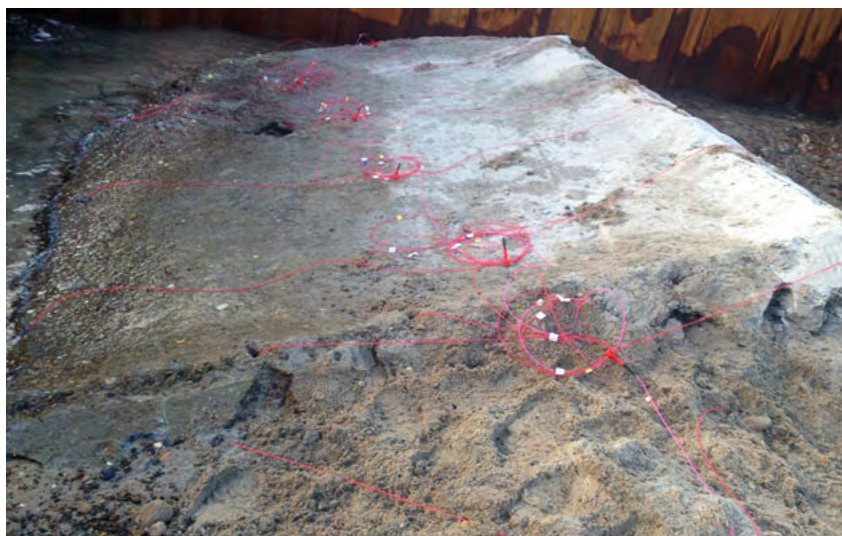
Del af bunker klargjort til sprængning
