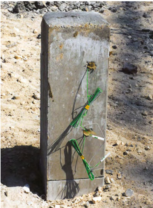
Forberedelse til sprængning af piloteringspæl
