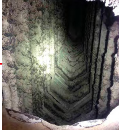
Rensede kedlerør før og efter sprængning
