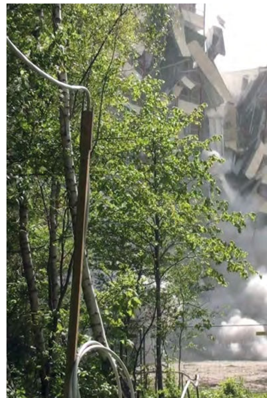
Sprængning af det andet hus, Agerkær. Det første billede viser sprængning i det to nederste etager og den begyndende sammenstyrtning i midten af huset. De næste to billeder viser den planlagte kollaps med hældning mod vest
