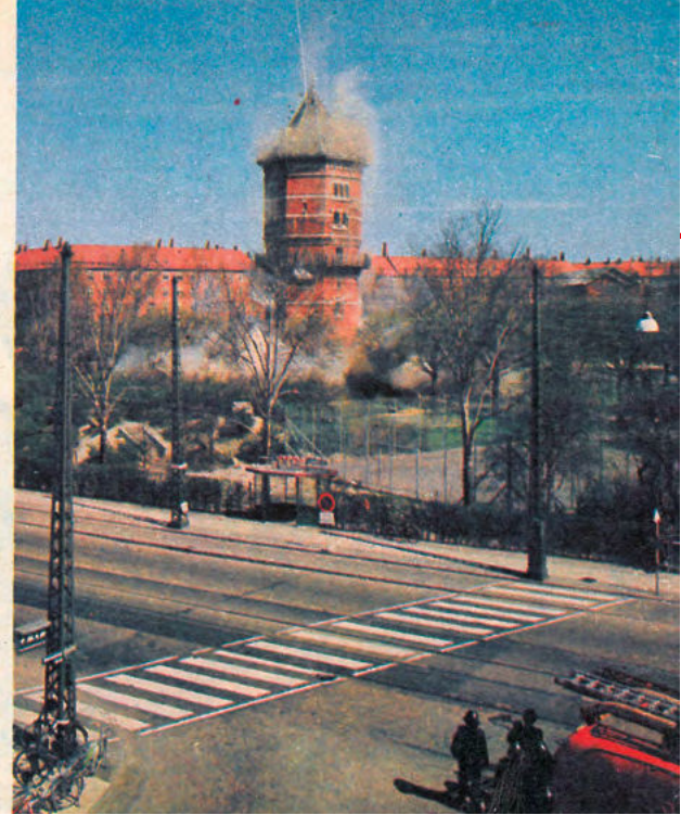
Sprængning af Sundby Vandtårn, 1967. For at få bedre virkning af sprængningen og for at dæmpe udkast fra sprængning var tårnet \frac{3}{4} fyldt med vand
