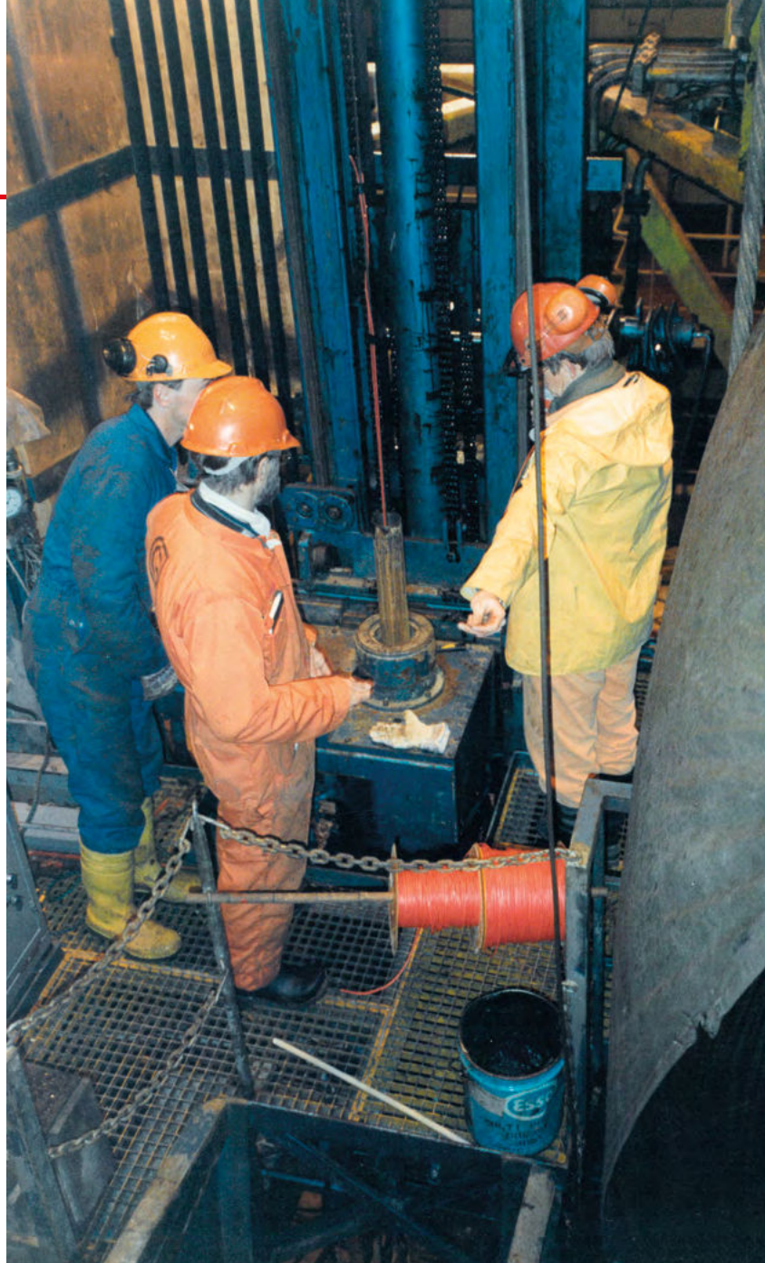
Ladningen fires ned i borerør
