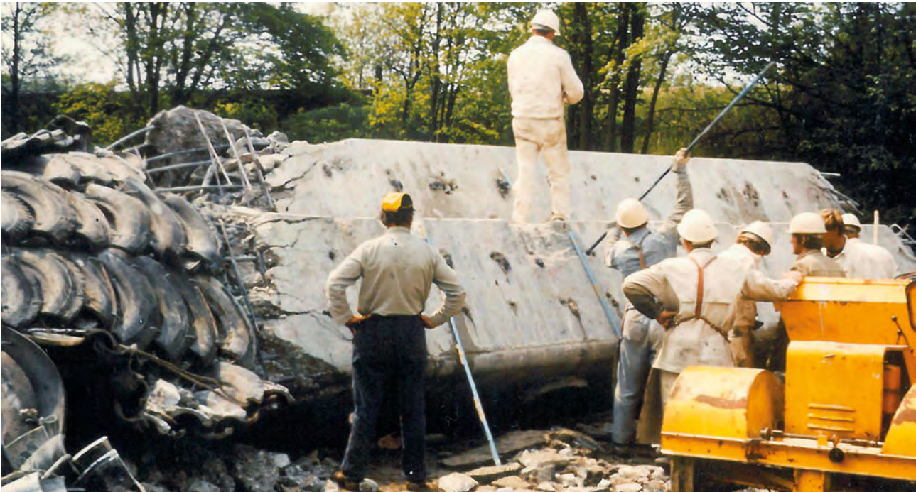
Forberedelse af nedstyrtet betonelement til sprængning med indborede sprængladninger
