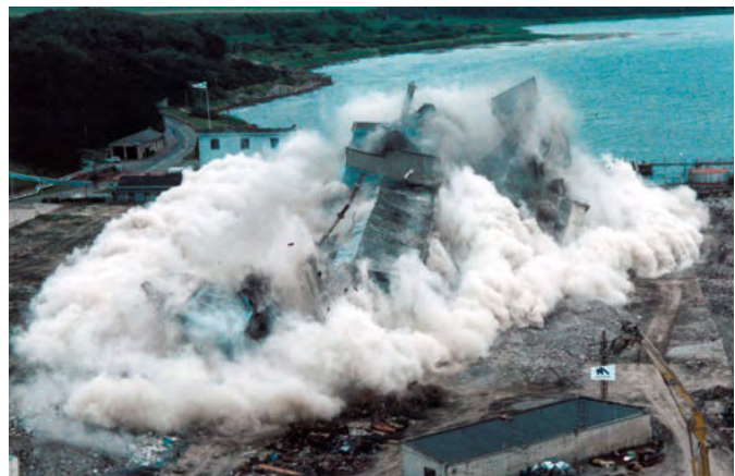
Sprængning af kraftværksbygningen afsluttede sprængningsopgaverne i forbindelse med nedrivning af det gamle Kyndbyværk
