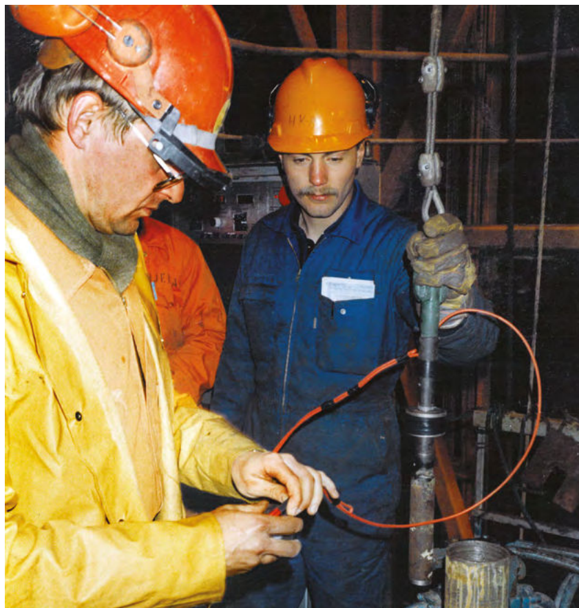
Jørgen Schneider, DEMEX, forbereder ladning til kapning af borerør. I midten af den røde sprængsnor ses den retningsbestemte ladning
