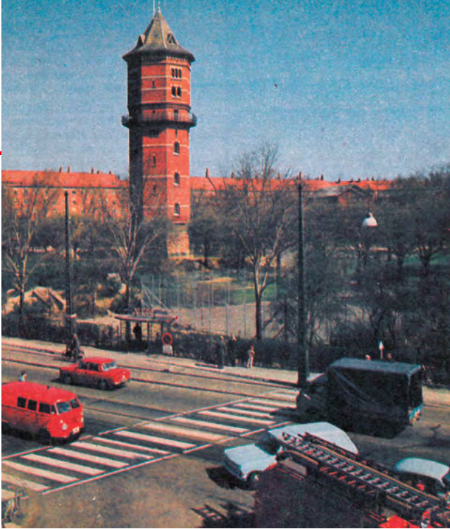
Sprængning af Sundby Vandtårn, 1967. For at få bedre virkning af sprængningen og for at dæmpe udkast fra sprængning var tårnet \frac{3}{4} fyldt med vand
