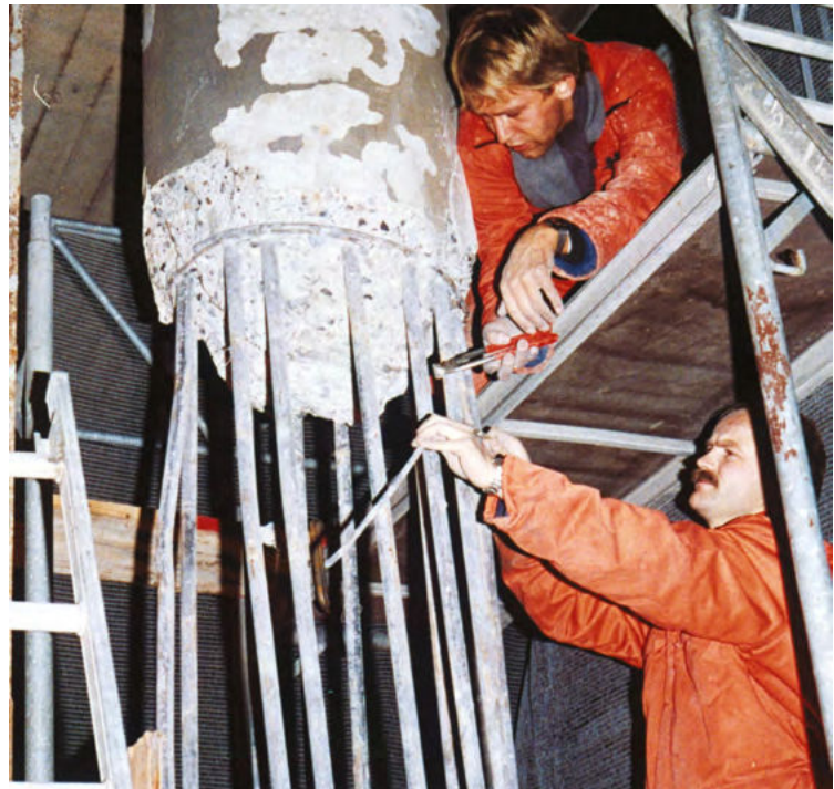
Erik "Chris" Thyrning og Poul Erik Hansen checker resultat af MINI-BLASTNING af søjle i motorvejsbro
