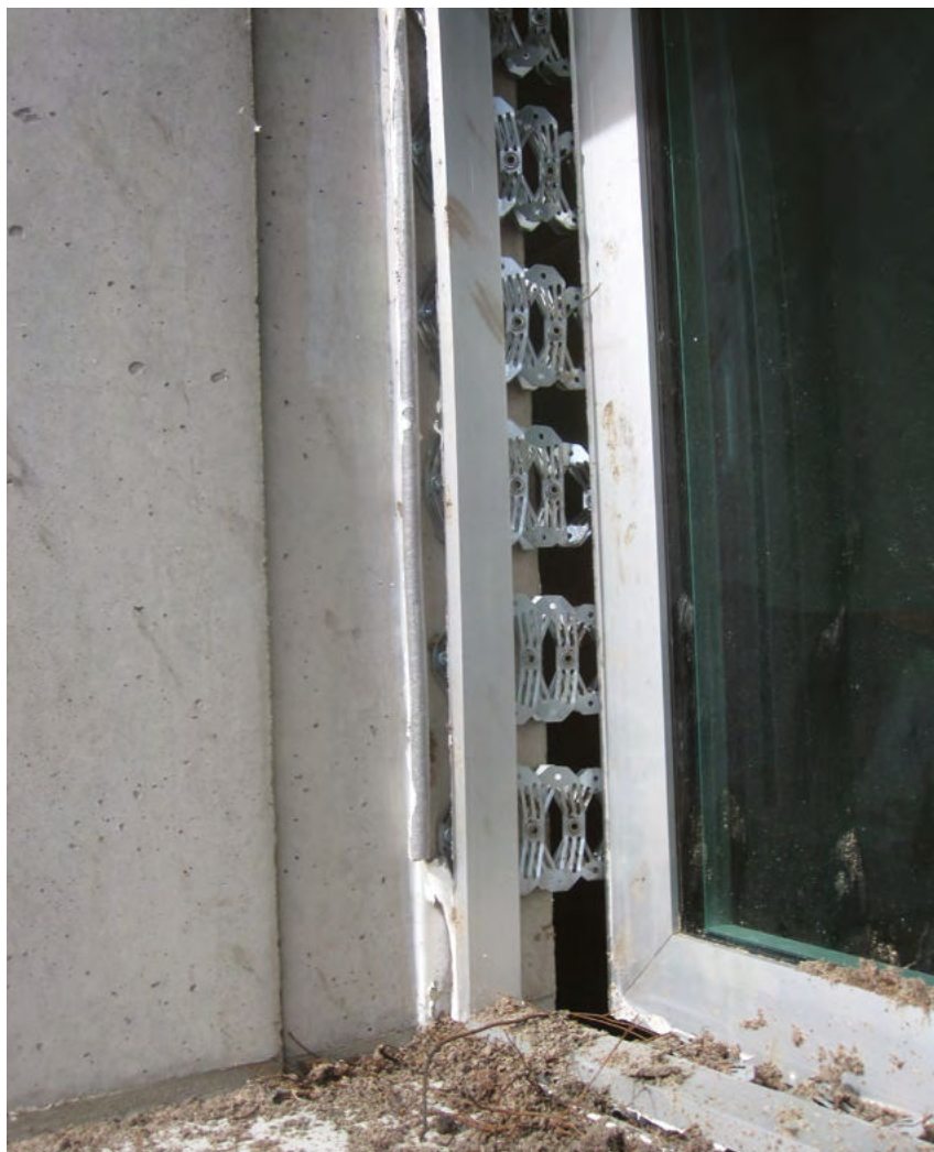
Dynamisk aflastning af vindue påvirket tryk fra eksplosion (Arpal Defender Technology)
