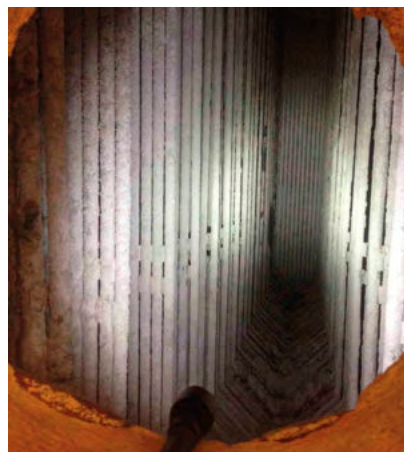
Rensede kedlerør før og efter sprængning
