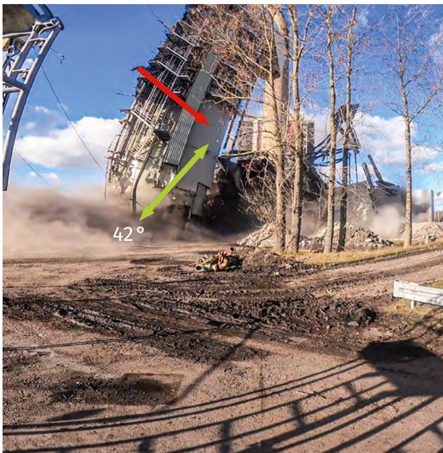
Abb. 8: Splitterflug, der Splitter ist in 5 Bildern nachweisbar, Foto: Lankes
