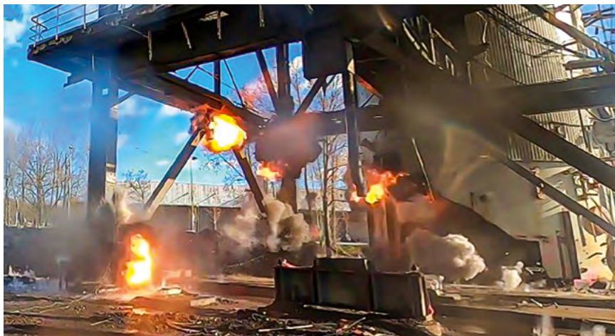
Abb. 2: Detonation Schneidladung und Schubladungen, Fotos: Lankes
