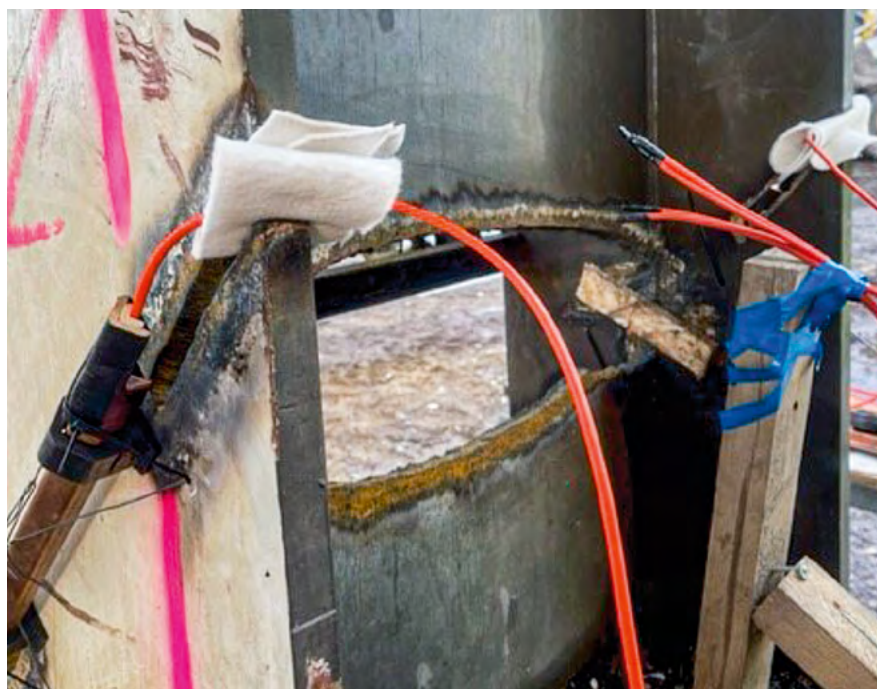
Abb. 1: Anbringung Schneidladung, Foto: Lankes
